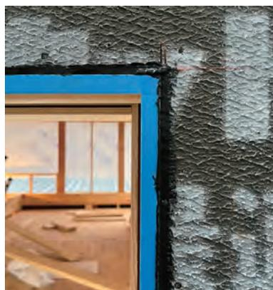
6. 壁と枠の取合いはシーリング材で捨て打ちしてください。
